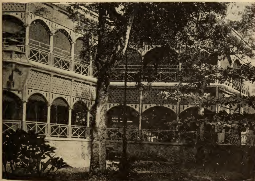
Fig. 17. — Hôpital colonial de Saïgon (pavillon principal).
